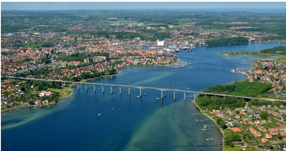
Luftfoto af den færdige Svendborgsundbro 1972.
