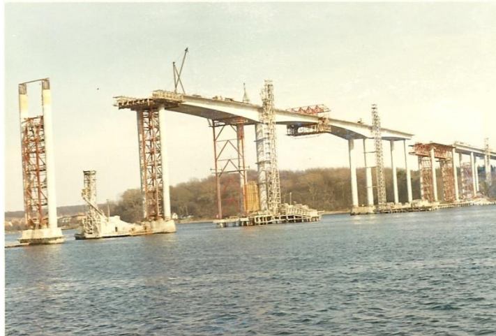
Sammenbygningen af broens 3 byggeafsnit nærmer sig. Sandsynligvis foråret 1966.
