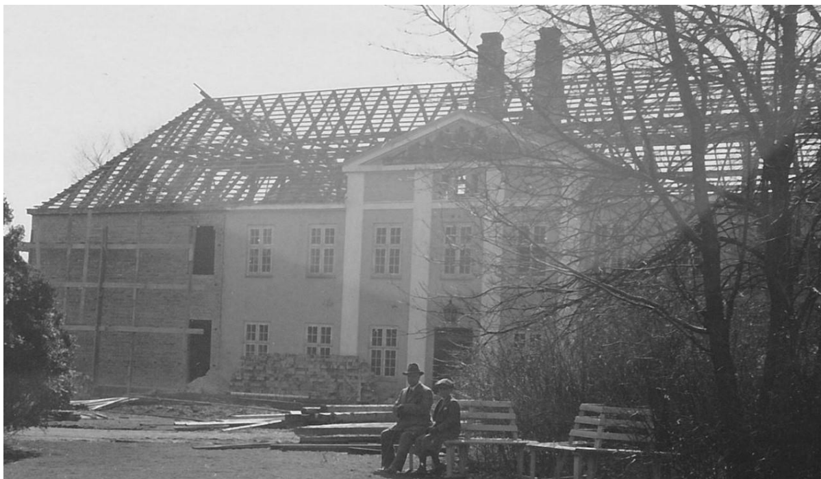
Hovedbygningen med ny tilføjet hjørnebygning og forberedelser til nyt tag.
