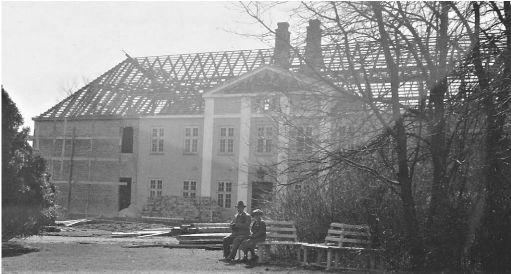
Ombygningen 1932 set mod hovedbygningens forside. Bemærk forlængelsen af bygningen i begge sider.
