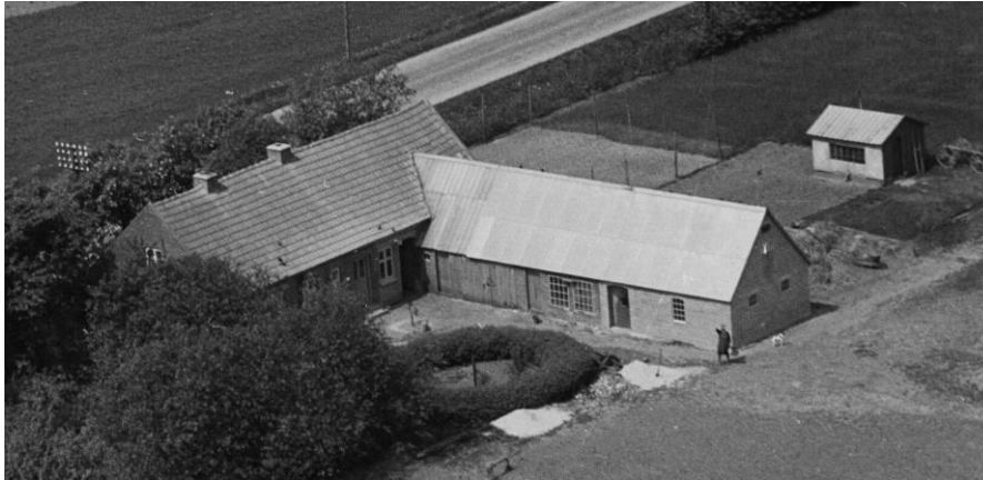
Luftfoto 1948 af ejendommen "Bakkelund". Nuværende adresse: Skjernvej 167, Nr. Felding, 7500 Holstebro.
