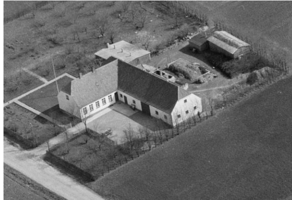
Luftfoto af husmandsbruget 1949 – ca. 17 år efter at Peter Knud Nielsen og familie forlod det. Både beboelsesfløjen og staldbygningen ser sandsynligvis stadig ud, som da husmandsbruget blev opført i 1927. Der er dog tilføjet et par udhuse bag den oprindelige bygning.
