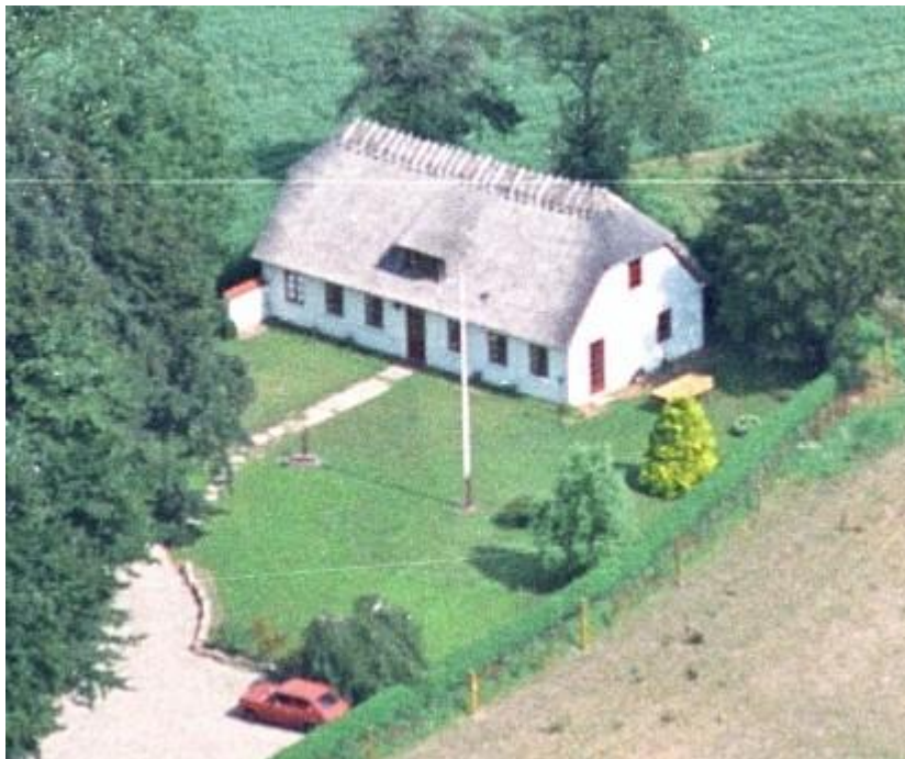
Luftfoto 1991 af den nyopførte ejendompå matrikel 31b i Oure. Nuværende adresse Landevejen 164, 5883 Oure.
