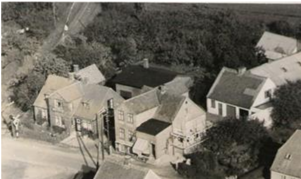
Nybyggeriet i gang ved sydgavlen – ny lukket veranda.
